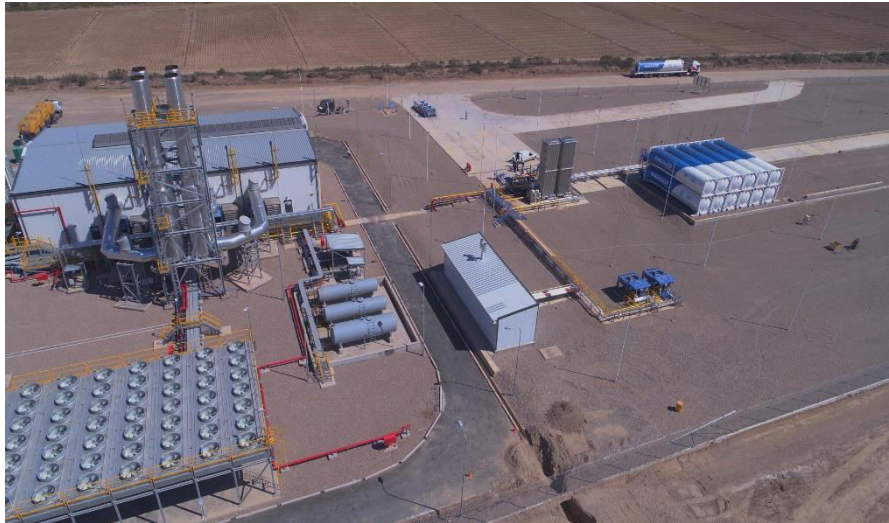
CENTRALES TERMICAS DE GENERACION ELECTRICA
